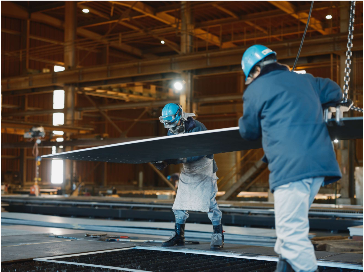
① 加工機へ鋼板の移動・据付・撤去
