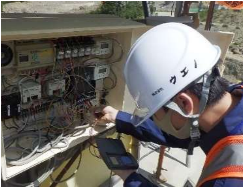
現地実習／観測施設の点検整備
